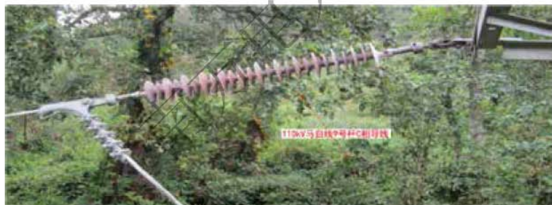
图3-4-2 110kV马白线9号杆C相大号侧复合绝缘子击穿
