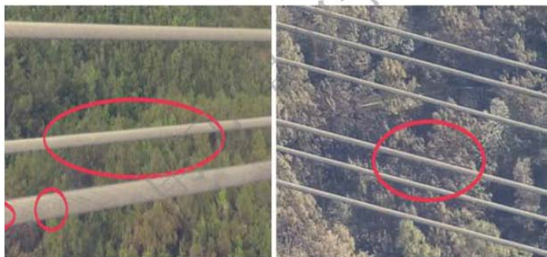
甲线B相导线放电点
