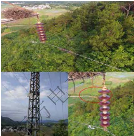
图3-6-7 N74塔B相绝缘子串故障点情况图
