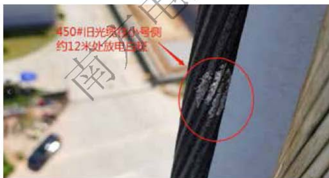
图3-7-9 #450C相小号侧约8m处右上、下子导线有多处明显放电白斑
