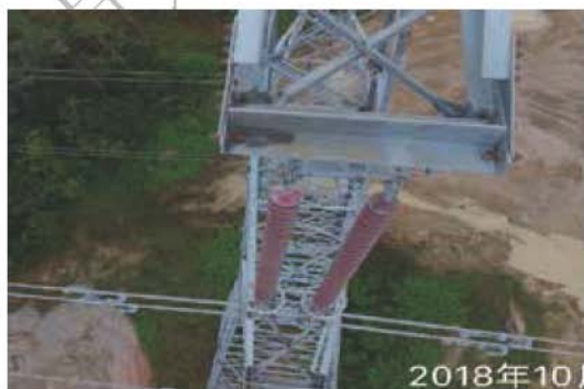
图3-5-7 220kV红牵 I 线N35塔B相复合绝缘子上有雷击灼伤点
