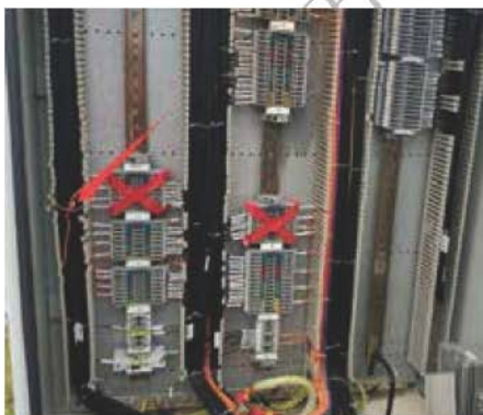
图3-8-3 绑扎槽盒电缆芯的黄色电缆线
