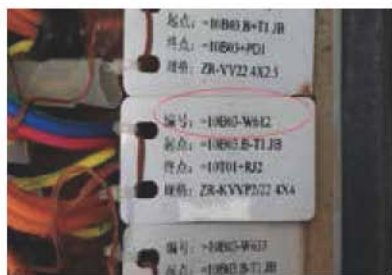
图3-8-2 不对应的电缆吊牌
