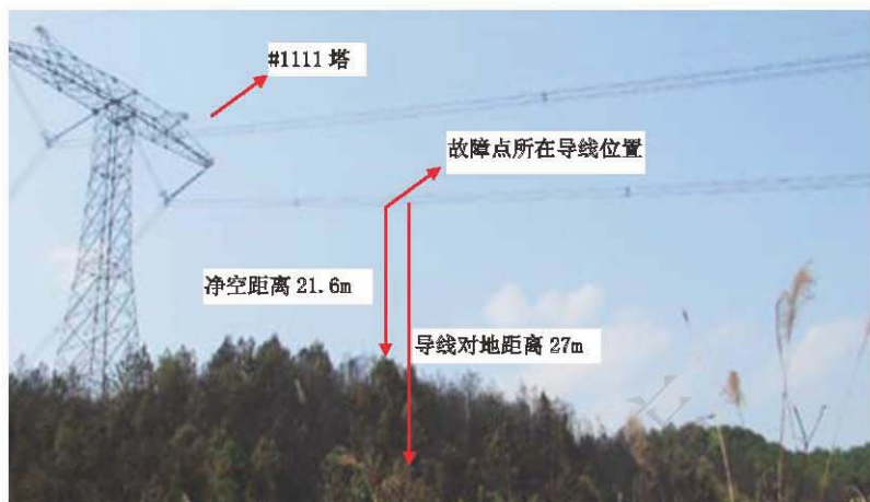
图3-2-5 ±800kV普侨直流线#1111故障点位置图
