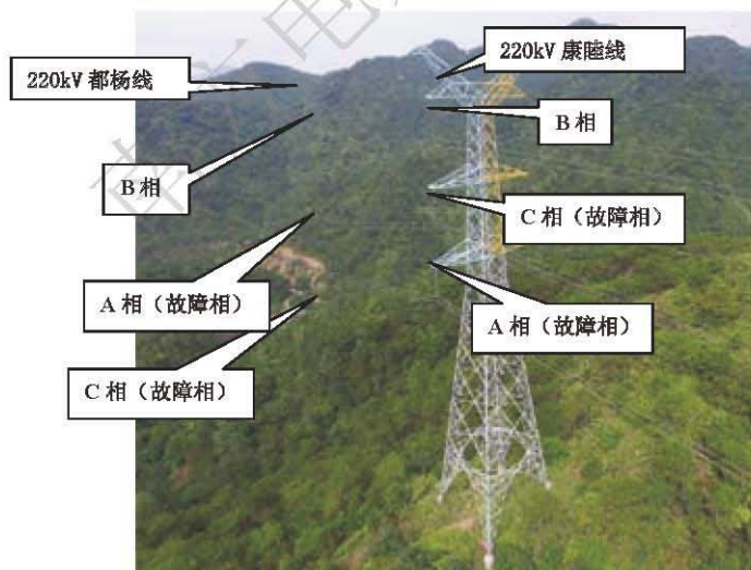
图3-5-3 220kV康睦线#86塔（220kV都睦线#69塔）全貌图
