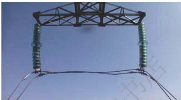
图3-17 利用4个并钩线夹临时抢修恢复的#20中相引流
